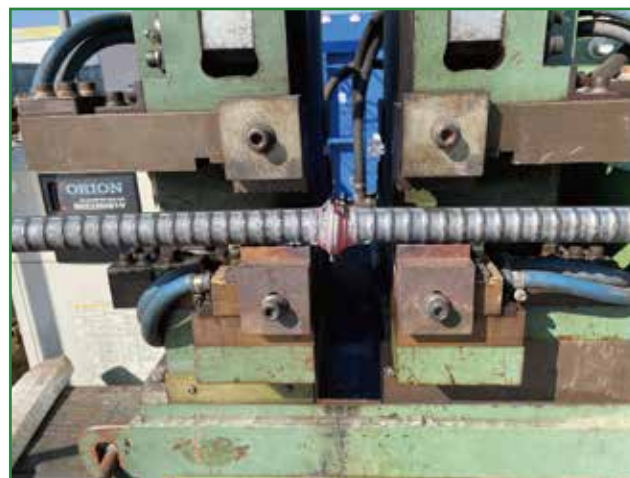
アップセットバット溶接状況2
