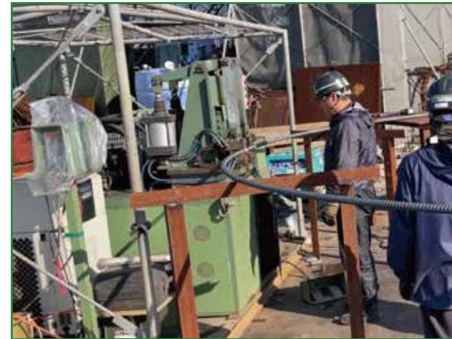
アップセットバット溶接状況1
