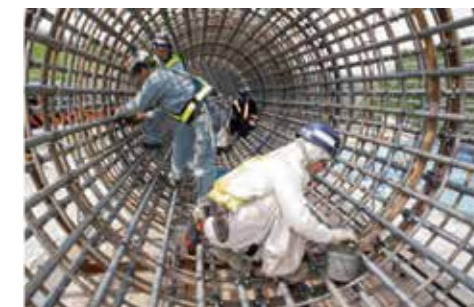
鉄筋を正確な位置で組立可能
