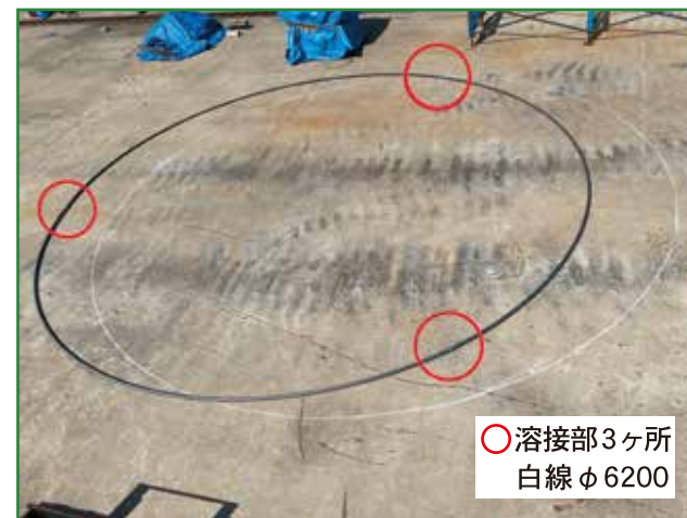
直径確認状況 溶接部確認
