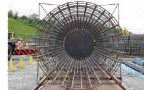
すべての鉄筋を仮置きにした状態
