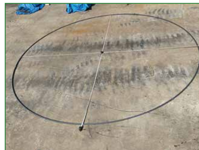
直径確認 白線合せ φ6200(鉄筋中心寸法)
