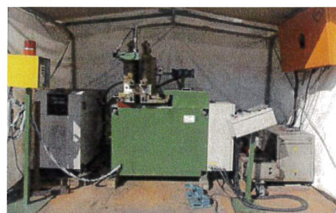
写真-2 機材設置状況
